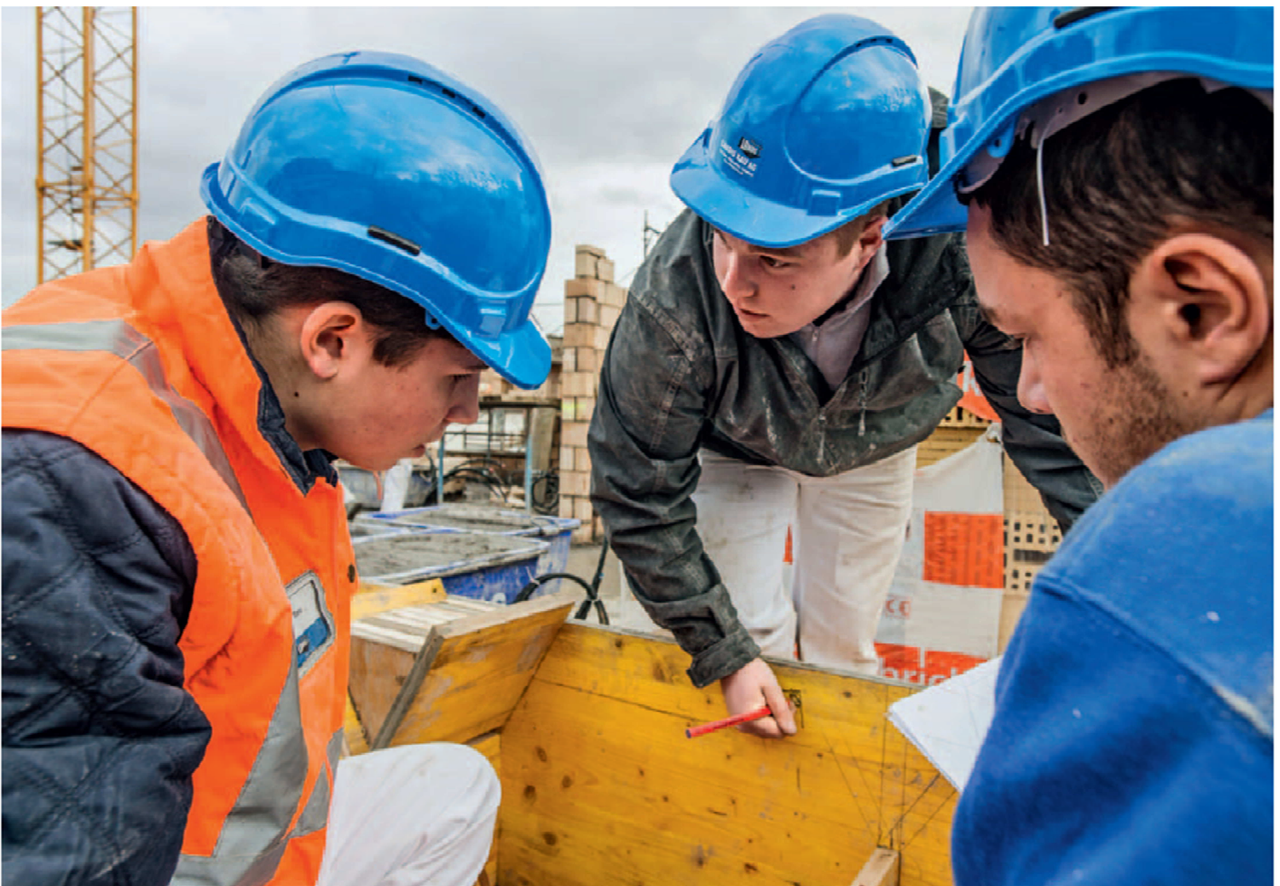
Lehrlinge der Landis Bau AG erstellen in Root LU ein Einfamilienhaus. Foto: Dennis Savini
