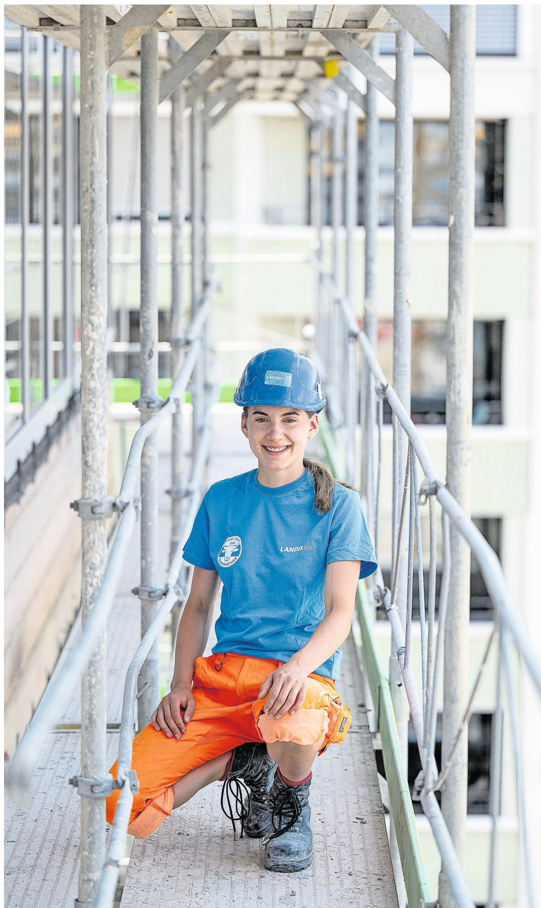
«Ich bin auf jeden Fall im Job angekommen.» Leandra Wolfisberg, hier auf der Baustelle auf dem Papierei-Areal. Bild: Maria Schmid (Cham, 17. 7. 2023)
