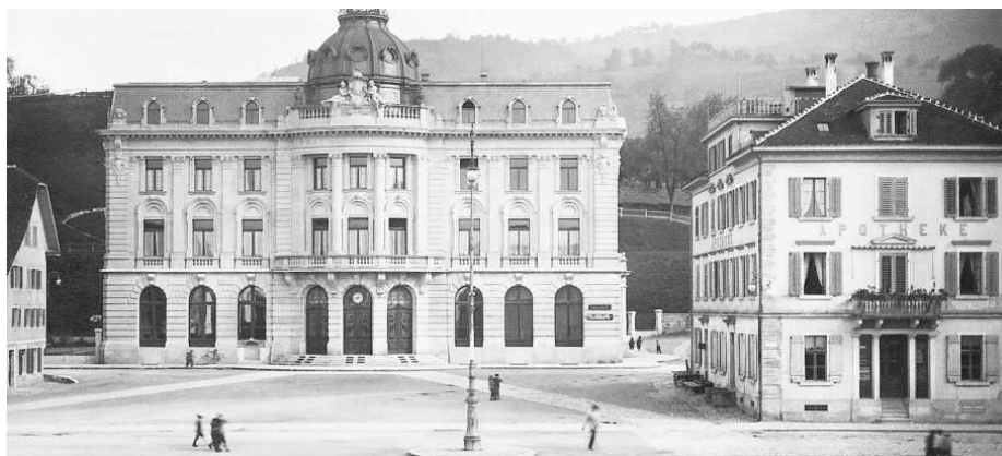
Das im Jahr 1902 eingeweihte Postgebäude in Zug, gebaut von Johann Landis.
