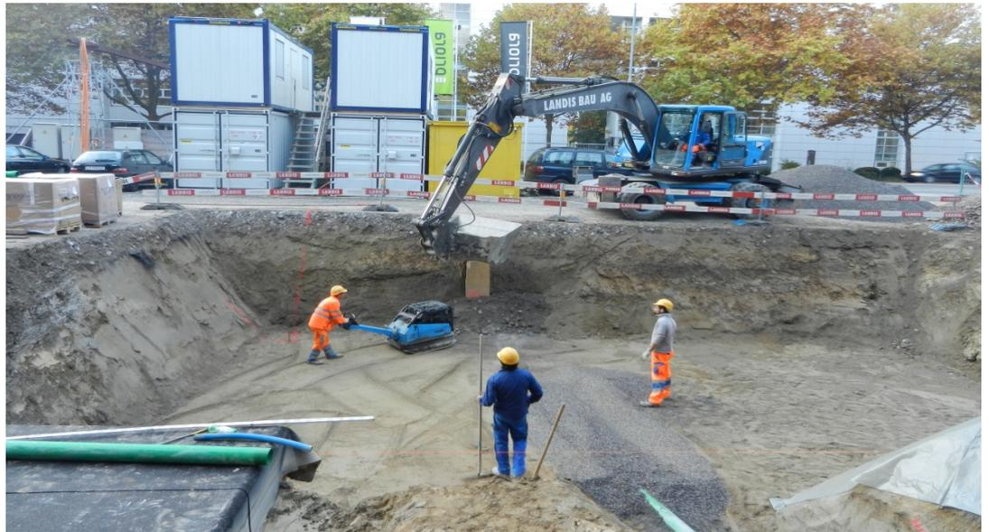
**Projektbeschreibung** Die Gebäudeentwässerung wird im Trennsystem aufgebaut.
