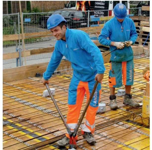
Roman Hagen ist der Chef auf der Baustelle
