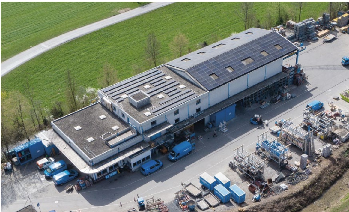
Werkhof in Deinikon, Baar mit Photovoltaikanlage und Elektrotankstelle
